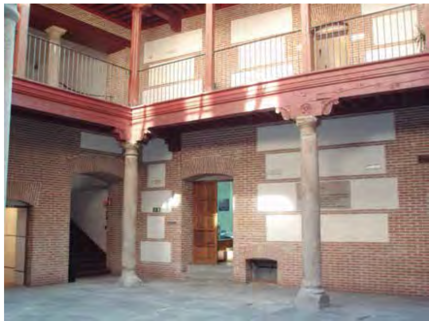
Patio interior en la sede de la FEMP.
